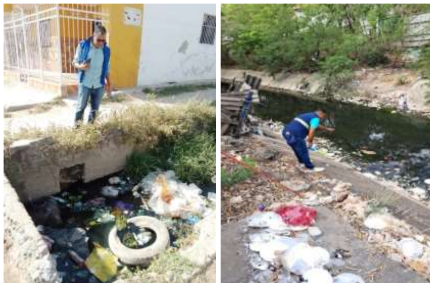
Imagen 4.18.1.6.2. sectores inspeccionados e intervenidos (caños).
